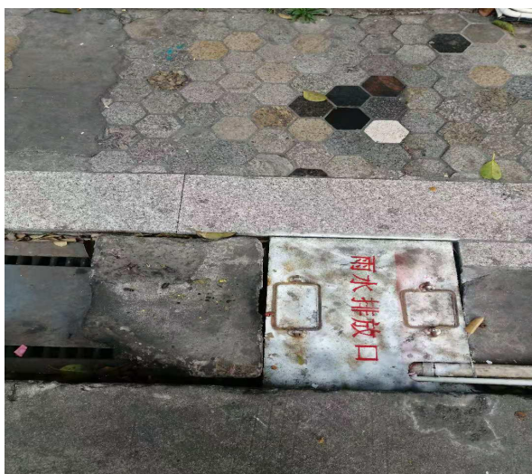
雨水总排放口
